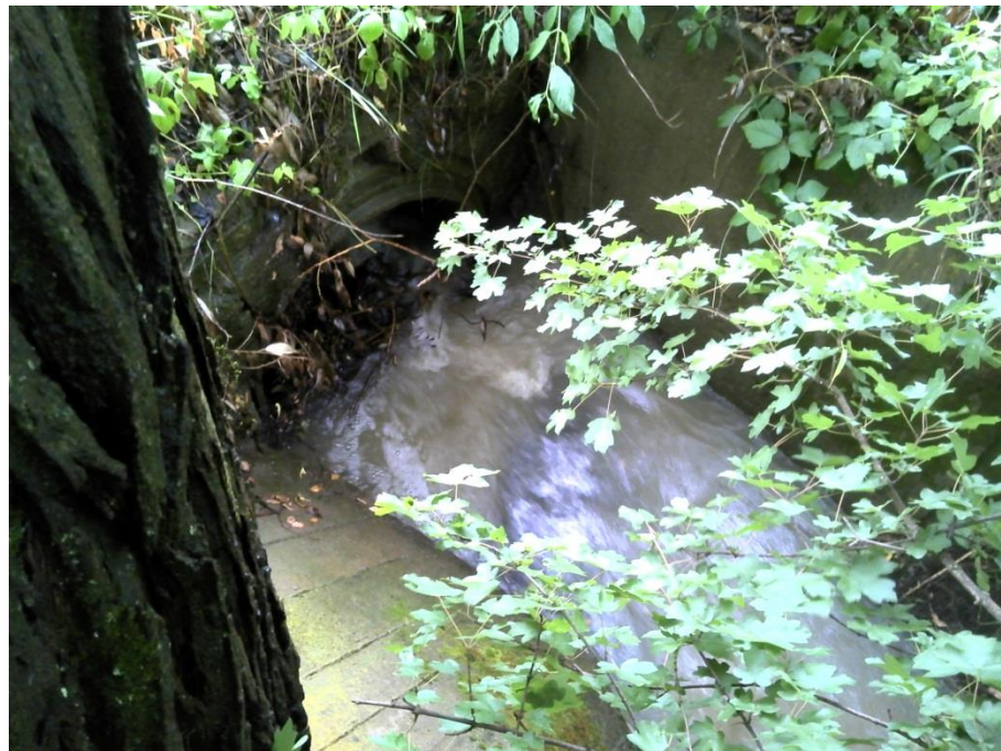
zanesené propustky
